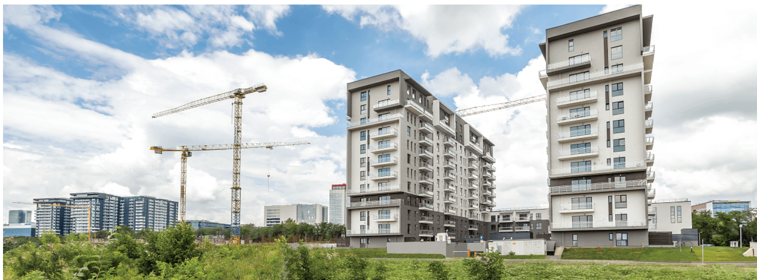
Șantier Belvedere Residence
