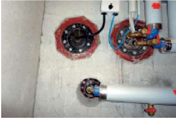
b. sistem etanș de conducte
