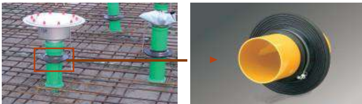
a. trecerea unei conducte de scurgere printr-o placă de fundație
