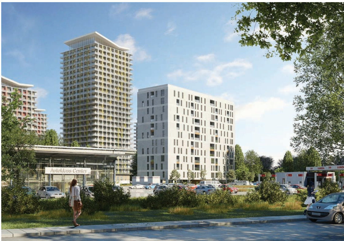
Proiect strada Glădiței
